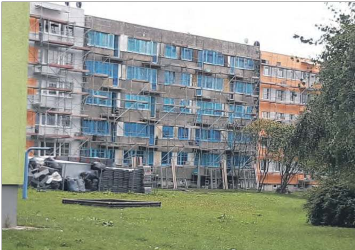
W tym roku kolejne budynki spółdzielni doczekają się kompleksowego ocieplenia
