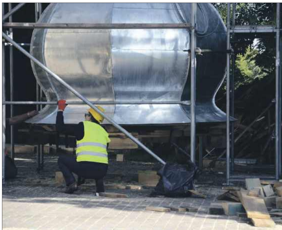
Ostatnie chwile wieży na ziemi - przed zamontowaniem.
