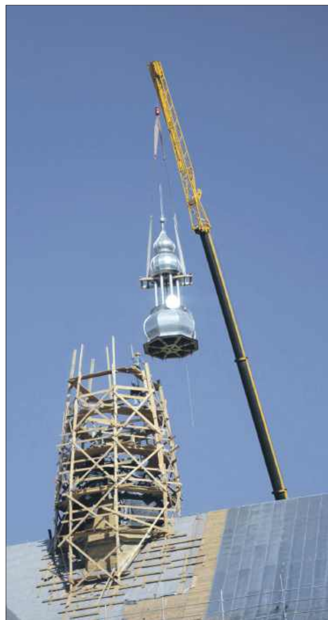
Wyciągnięciem wieży na dach zajął się specjalny dźwig z Mielca. Cała operacja wzbudziła spore zainteresowanie.
