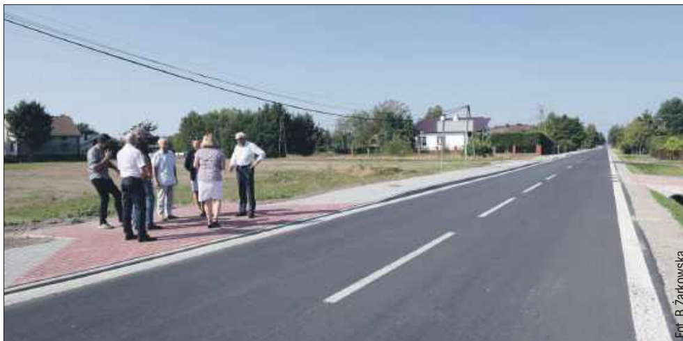
Obecny rok jest bardzo obfity w realizację zadań na drogach powiatowych. Na ich realizację Powiat Kolbuszowski pozyskał bardzo duże dofinansowania ze źródeł zewnętrznych, dzięki czemu może przystępować do wykonywania inwestycji potrzebnych i oczekiwanych przez mieszkańców
