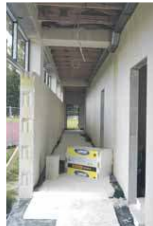
Po prawej stronie pawilonu, patrząc od strony ulicy Fabrycznej, będą szatnie i natryski dla drużyn oraz sędziów
