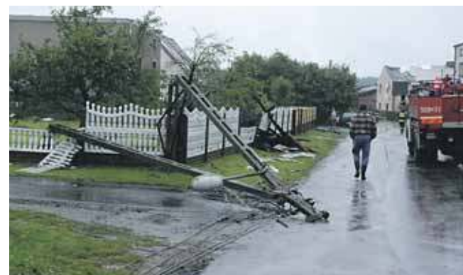
Przewrócone słupy i zerwane sieci energetyczne na początku stwarzały niebezpieczeństwo porażenia
