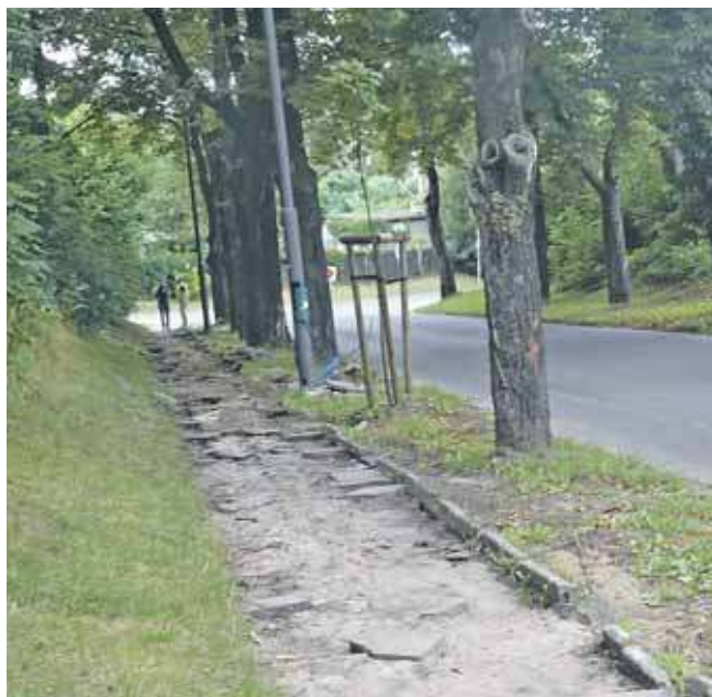
Nie wiadomo, kiedy będzie koniec prac
