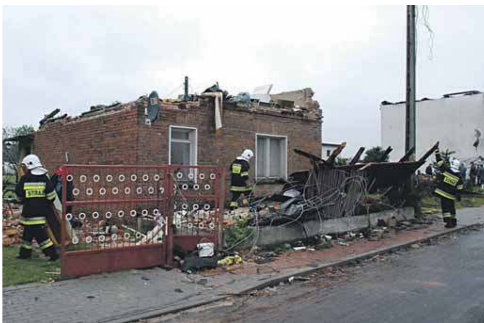
Tornado zniszczyło dziesiątki domów
