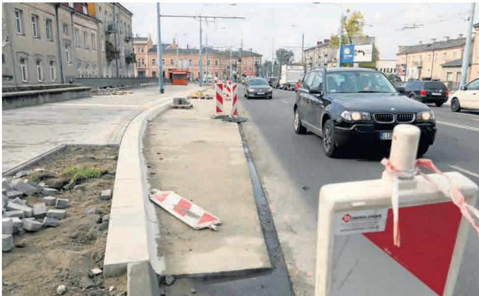
Nowe zatoki przystankowe w okolicy ul. Wolskiej mają być gotowe połowie października
