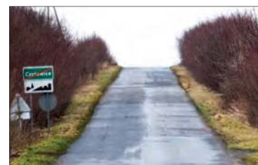
Dofinansowaniem objęty zostanie remont drogi z Prudnika do Czyżowic
