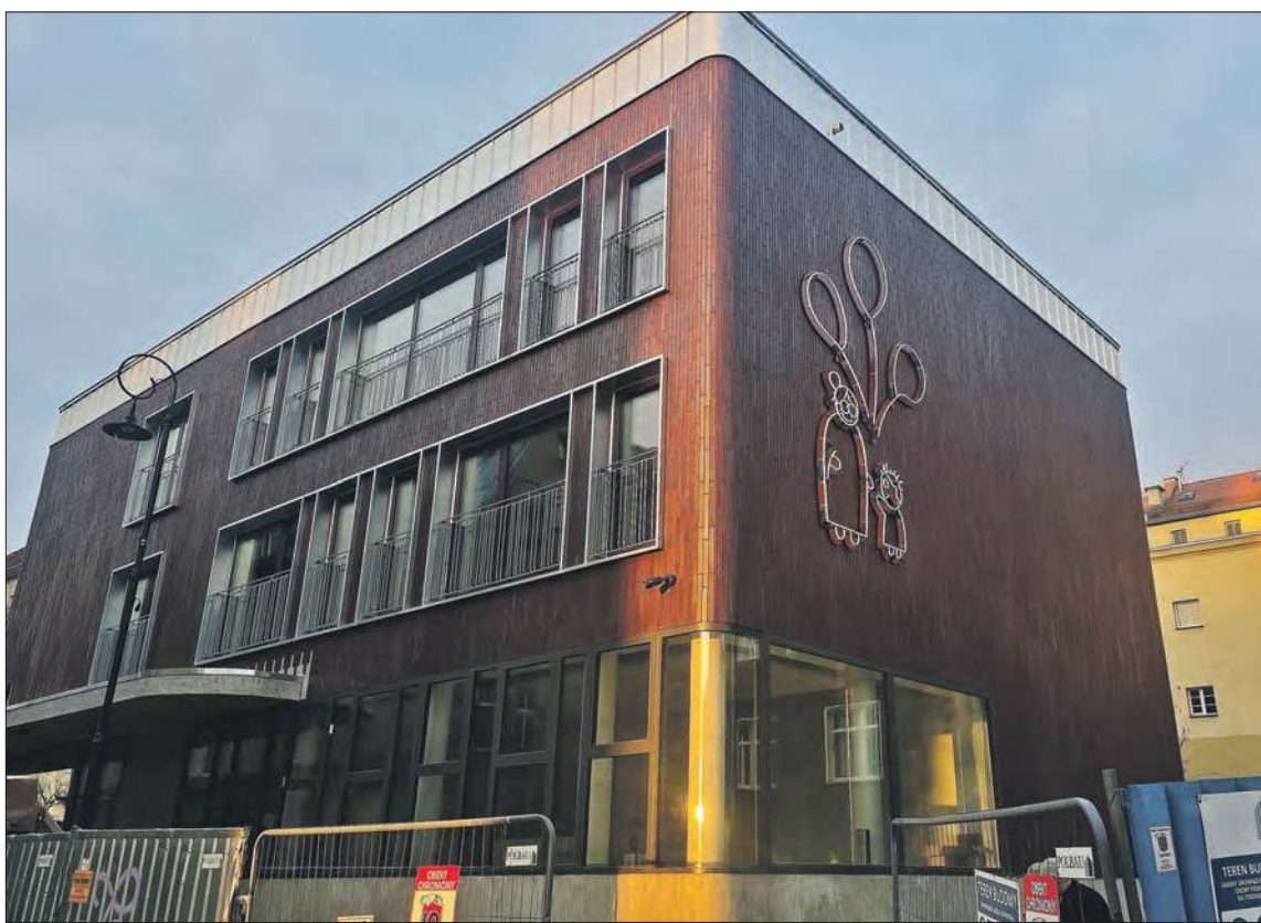
Nowy obiekt w centrum Prudnika będzie pełnił funkcje prospołeczne
