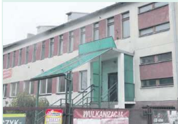
Gmina Wiązów otrzymała ok. 1,7 mln zł na modernizację budynku po byłym Banku Spółdzielczym w Wiązowie
