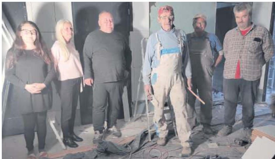
Trwa odbudowa przetwórnicy. Na zdjęciu (od lewej): Malwina, Monika i Marek Michniewiczowie z pracownikami
