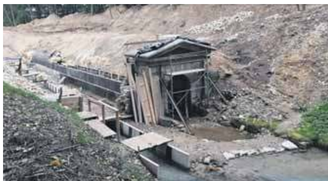
Tak wyglądał wylot sztolni jesienią ubiegłego roku, podczas remontu
