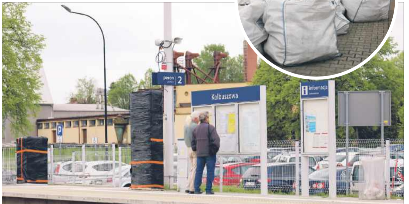
Na stacji widoczne są jeszcze niedziałające, ofoliowane urządzenia.
