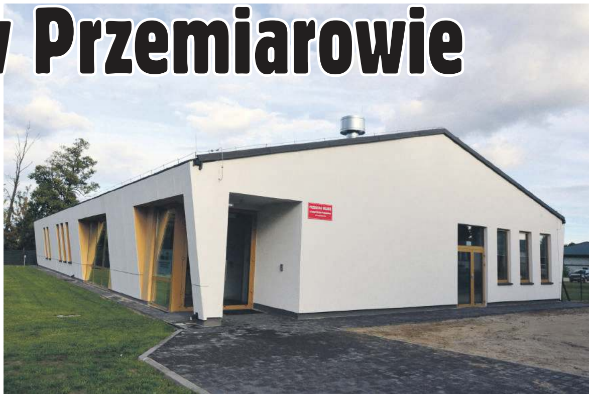
Budynek przedszkola w Przemiarowie w dniu otwarcia. Wrzesień 2022 r.
