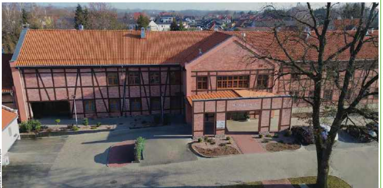
Szpital Powiatowy w Pasłęku sp. z o.o.
