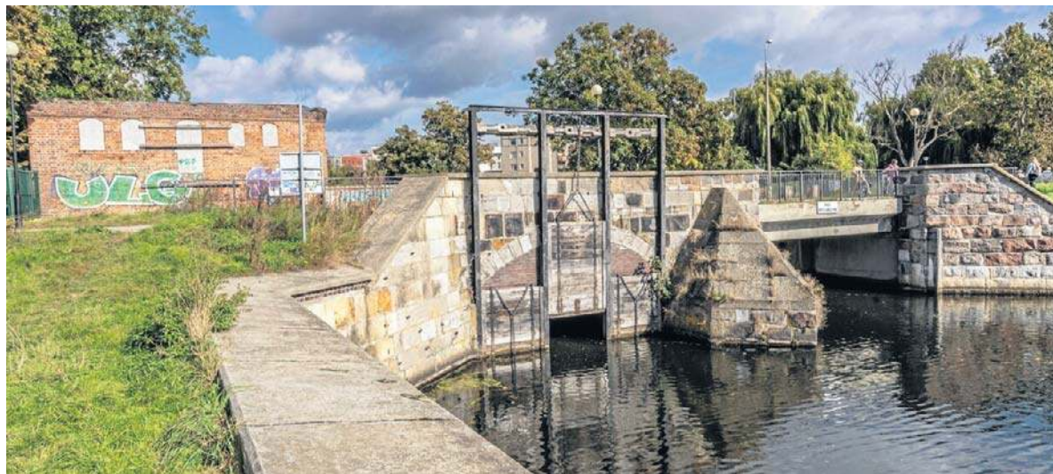
Fragment śluzy. Całość wygląda dziś inaczej niż pierwotnie, z uwagi na dokonane przebudowy i wymianę urządzeń. Niegdyś między innymi zapobiegała cofaniu się wody morskiej na Żuławy
