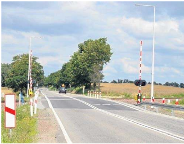
Przy okazji przebudowany zostanie przejazd kolejowy
