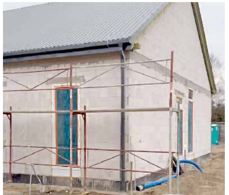
Miejski Żłobek jeszcze w budowie
