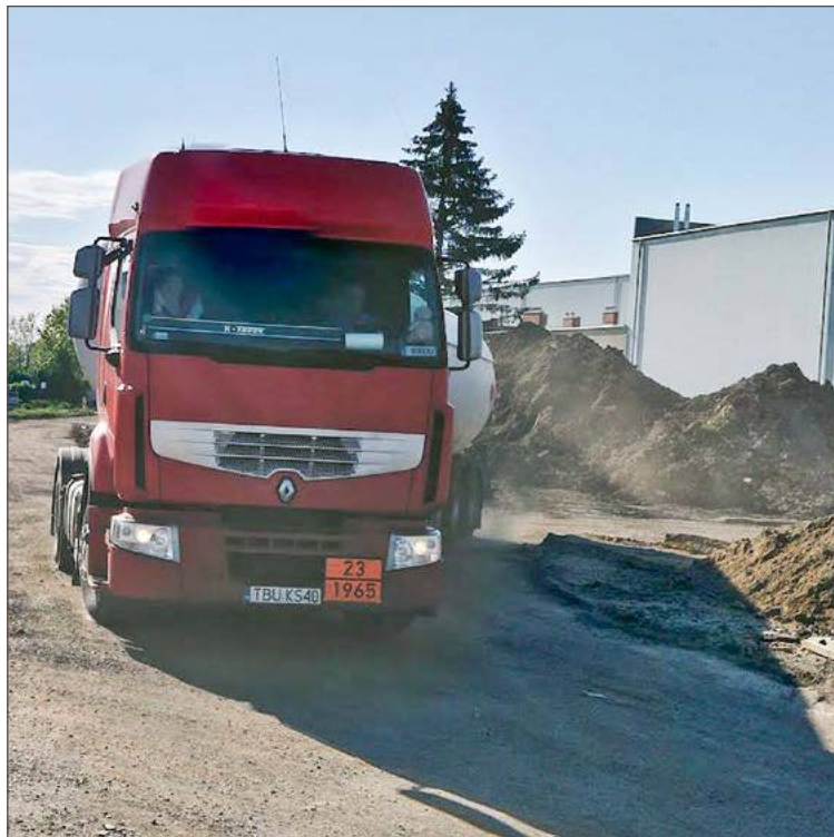
Okolice WUCH to teraz jeden wielki plac budowy.
