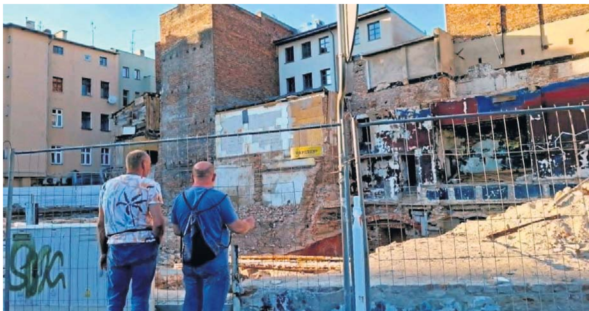
Budowa hotelu w Starym Browarze w Toruniu stanęła w maju, a wznowiona zostanie w październiku
