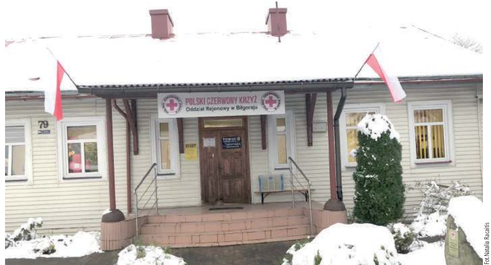
Budynek przy 3-go Maja 79 w Biłgoraju, w którym znajduje się siedziba PCK, został wybudowany w czynie społecznym w 1928 roku. Hrabia Zamojski dał drewno na ten budynek. W 1931 roku został oddany do użytku z myślą, żeby służył on organizacji PCK. To w tym budynku znajdowały się pierwsze przychodnie w Biłgoraju i pierwsza stacja pogotowia ratunkowego
