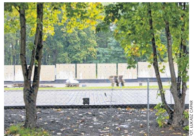
Postępy prac przy budowie kolumbarium
