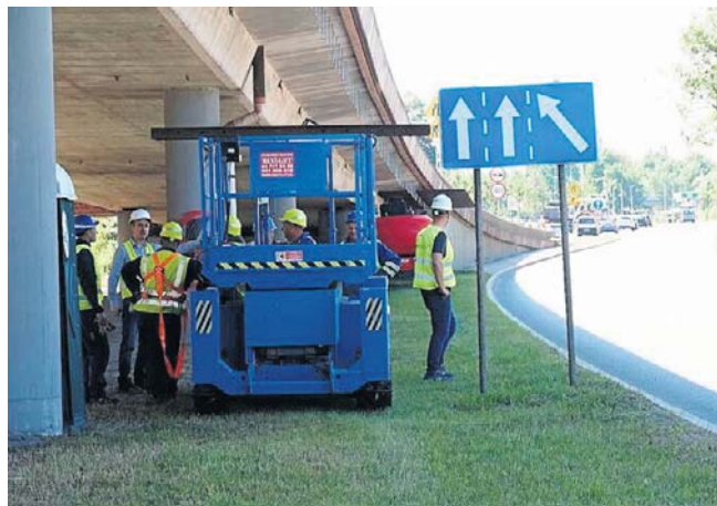
Prace obejmą konserwację, naprawę lub wymianę każdego elementu ponad półkilometrowej konstrukcji
