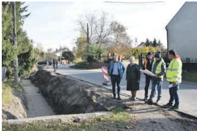
Wizytacja na budowie ciągu pieszo-rowerowego w Szewcach wzdłuż ulicy Strzeszowskiej
