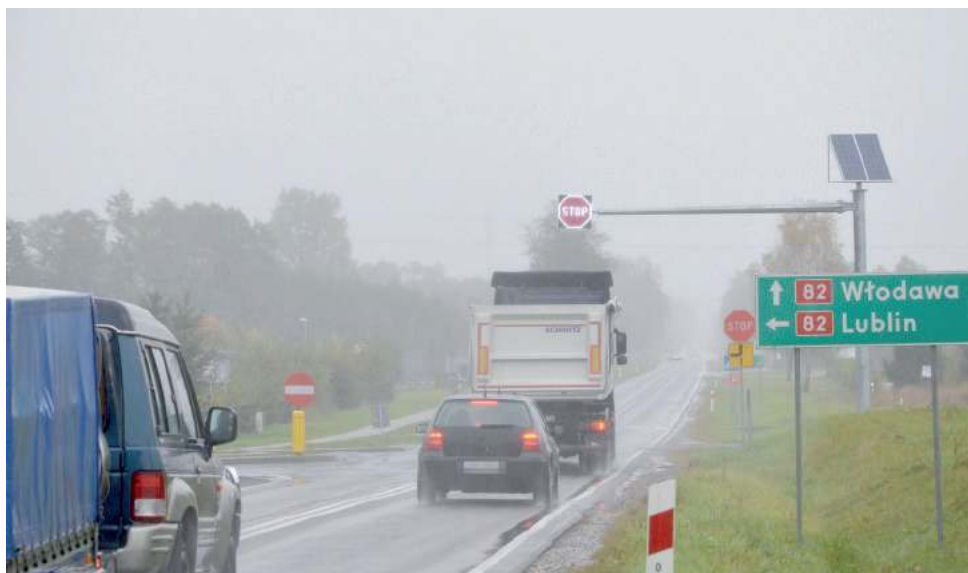
Skrzyżowanie w Głębokiem - widok od strony Trawniki, w lewo - do Łęcznej, prosto - na Cyców. Dochodzi tu do kolizji wynikających z nieustąpienia pierwszeństwa przejazdu. Na skrzyżowaniu drogi krajowej 82 z wojewódzką 838 w Głębokiem wielu kierowców wjeżdża nie patrząc na znaki i nie zatrzymując się. Znaki aktywne poprawiły sytuację, ale uwaga wciąż zawodzi kierowców, szczególnie nietutejszych
