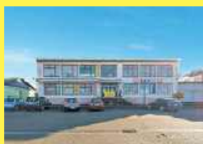
Dom handlowy w samym centrum Janowa Podlaskiego, 885 851 161
