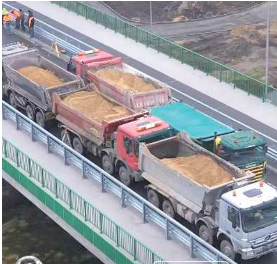
Próba obciążeniowa nowego mostu na Krznie
