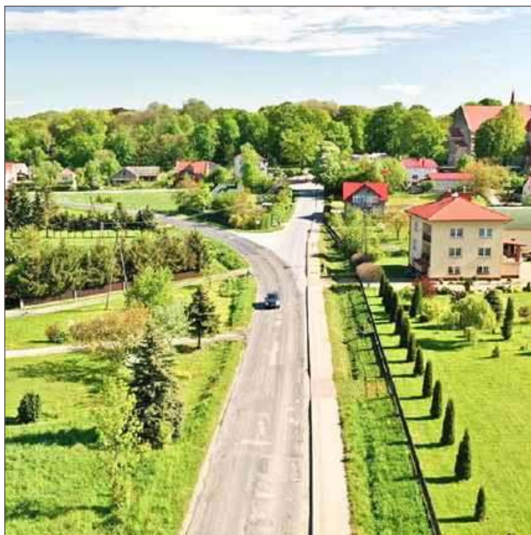
Droga wreszcie doczekała się przebudowy.
