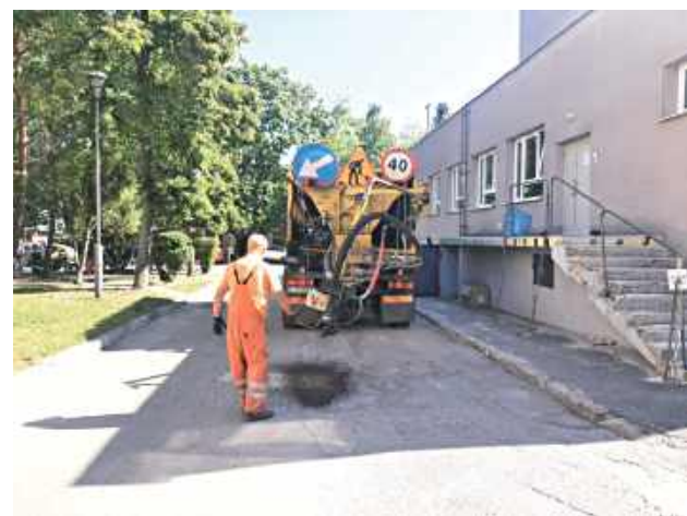
Wszystkie prace zostały wykonane przez ZDP własnymi siłami, bez angażowania firmy zewnętrznej
