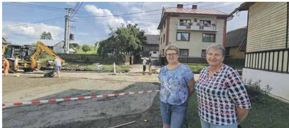
Mieszkańcy ul. Na Brzegu są pełni obaw w związku z trwającym już remontem ich drogi.
