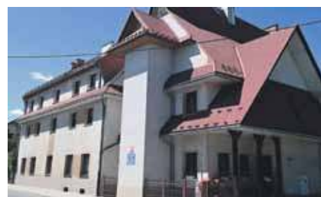
Budynek liceum zyska nową stolarką okienną i termomodernizację, która pochłonie aż milion złotych.
