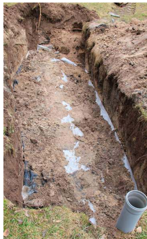
❗ Przed zasypaniem ziemią drenaż ostania się geowłókniną. J. WERNER
