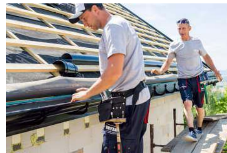
Montaż haków i rynien. CELL-FAST
