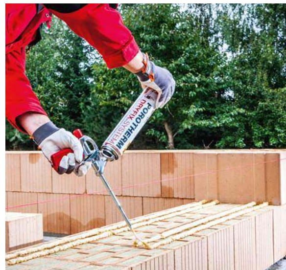
🔧 Użycie aplikatora pianki pozwala precyzyjnie wykonać spoiny. Dzięki temu ściana jest jednolita, wolna od liniowych mostków termicznych. WIENERBERGER
