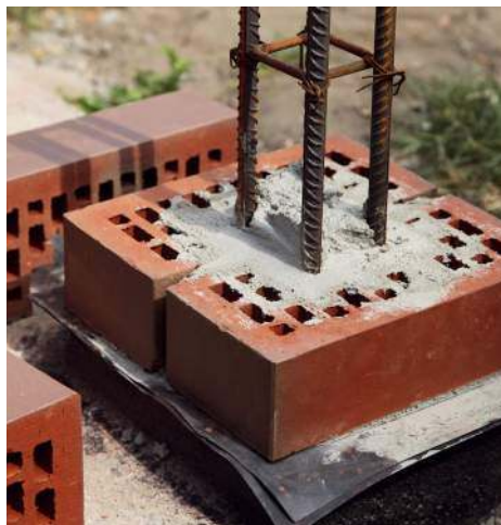
🔧 Stupy murowane z cegieł wymagają od wewnątrz wzmocnienia za pomocą metalowych prętów. RÖBEN
