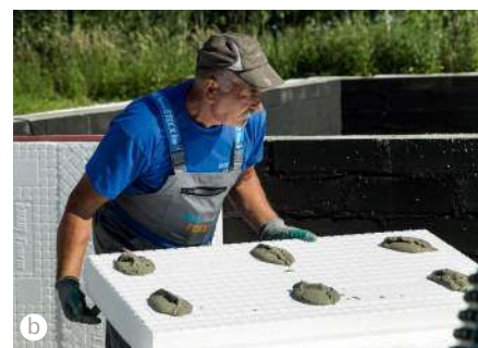
Styropian z domieszką grafitu (a TERMO ORGANIKA) ma nieco lepsze właściwości termoizolacyjne niż biały (b KNAUF THERM), można więc ocieplić ściany cieńszą jego warstwą.
