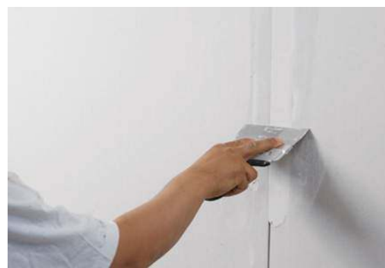
🔗 Miejsca łączeń płyt g-k wykańcza się masą szpachlową – dzięki temu powstaje jednolita płaszczyzna. KLEIB, PPG
