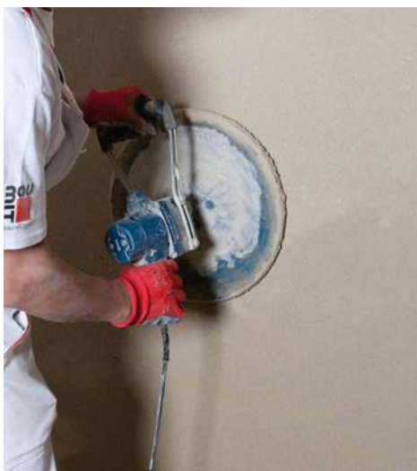
🔧 Wyrównywanie wstępnie związanego tynku za pomocą łąty (a) oraz zacieranie końcowe (b). BAUMIT
