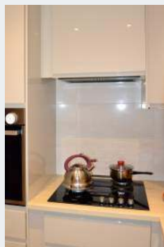
W laminowanym blacie szerokości 60 cm oprawiono płytę gazową, nad nią (w wiszącej szafce) – okap.
