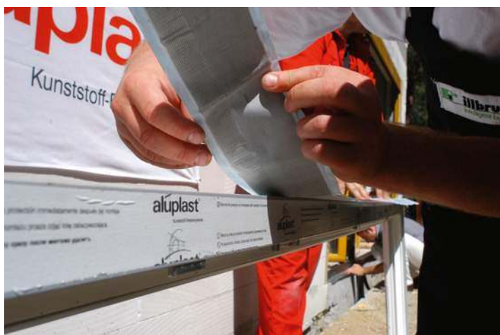
🔧 Aby nie dopuścić do zawilgocenia pianki montażowej, należy zastosować tzw. montaż warstwowi, z użyciem taśm zabezpieczających. ALUPLAST, REHAU
