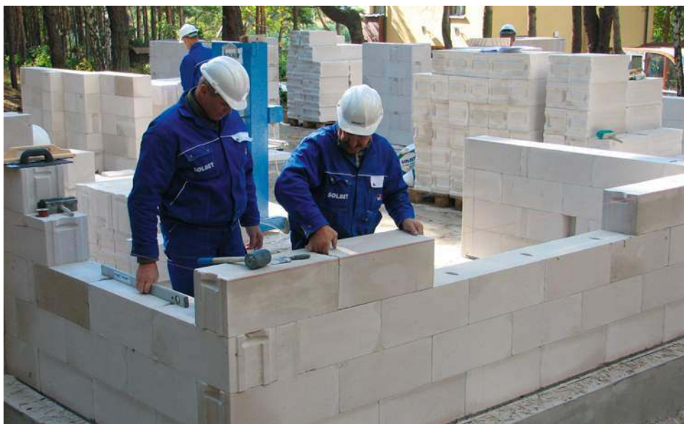
🔧 Budowa ścian z betonu komórkowego przebiega szybko, bo bloczki są lekkie i duże – na 1 m 2 muru przypada tylko 7 elementów. SOLBET
