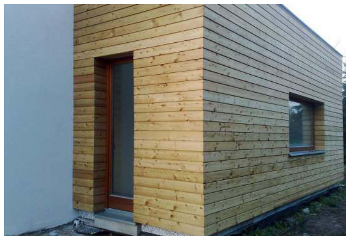
➎ Gotowa elewacja.
