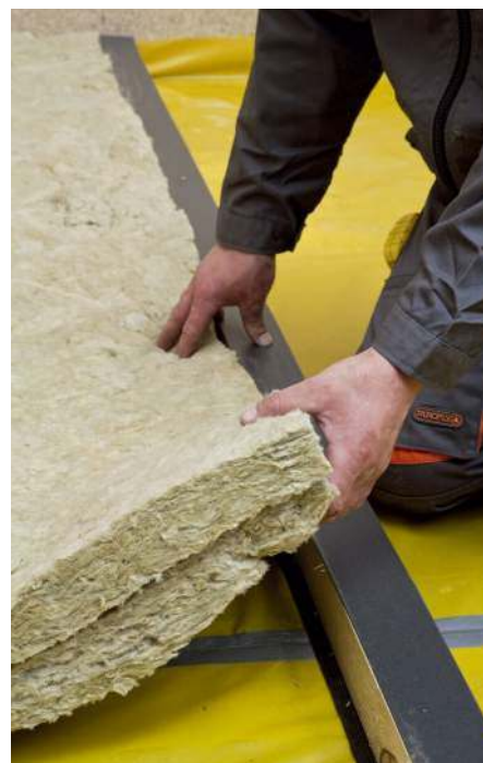
🔧 Wypełnienie przestrzeni między belkami ociepleniem z wełny mineralnej. PFLEIDERER
