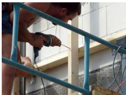
➊ Przytwierdzanie podkonstrukcji drewnianej.
