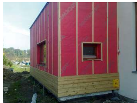
➌ Zabezpieczenie termoizolacji wiatroizolacyjną membraną.
