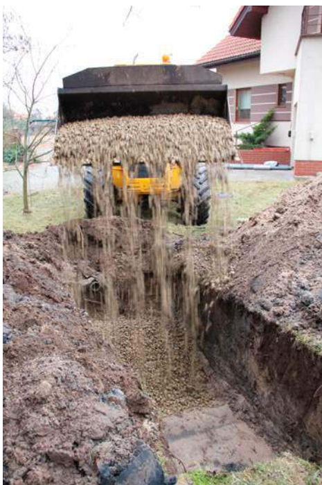
❗ Pakiety drenazowe z tworzywa zastąpiono tradycyjnym rozwiązaniem, czyli warstwą 12 t kruszywa. J. WERNER
