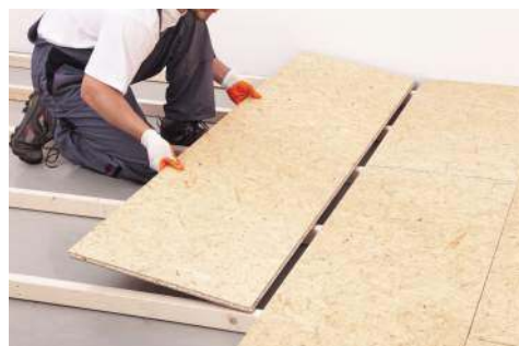
🔧 Ułożenie podkładu z płyt drewnopodobnych przed wykończeniem posadzki. KRONOPOL, KNAUF
