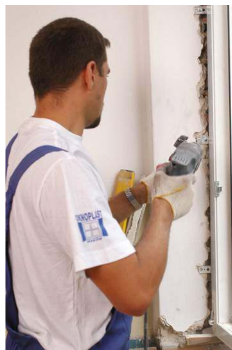
🔧 Ramy okienne muszą być solidnie zamocowane do ościeży. Używa się do tego kołków rozporowych. OKNOPLAST
