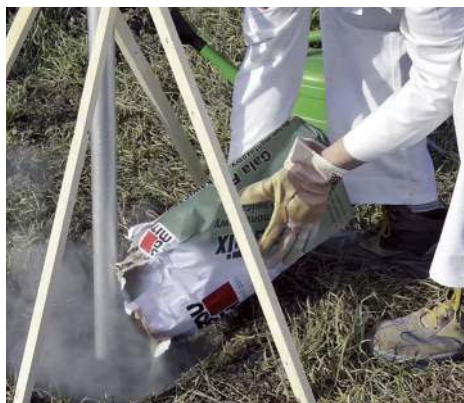
🔧 Ogrodzenia systemowe montowane na słupkach zwykle nie wymagają fundamentu na całej długości. Wystarczy wykonać punktowo stopy fundamentowe, w których osadza się słupki. BAUMIT
