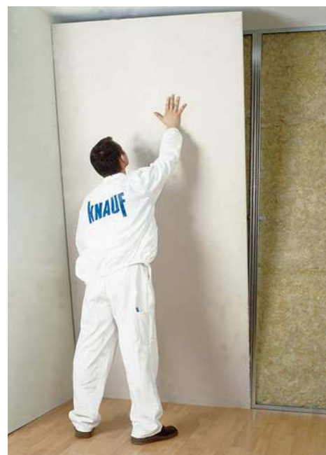
🔗 Montaż płyt gipsowo-kartonowych (suchego tynku) na profilach stalowych pozwala na docieplenie przegrody (umieszczenie w niej izolacji z wełny mineralnej). KNAUF
