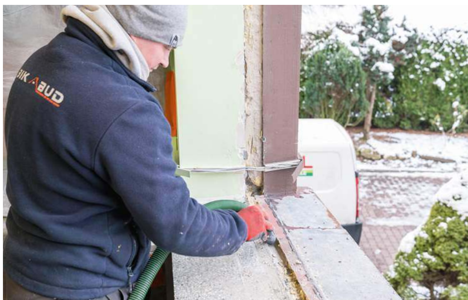
🔧 Po zdemontowaniu starych okien trzeba wyrównać ościeże – usunąć wszystkie wystające fragmenty muru i uzupełnić ubytki. KRISPOL
