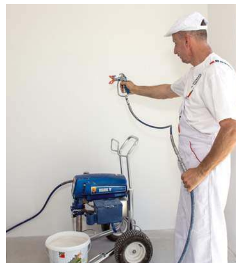
🔧 Natryskiwanie tynku agregatem. BAUMIT
