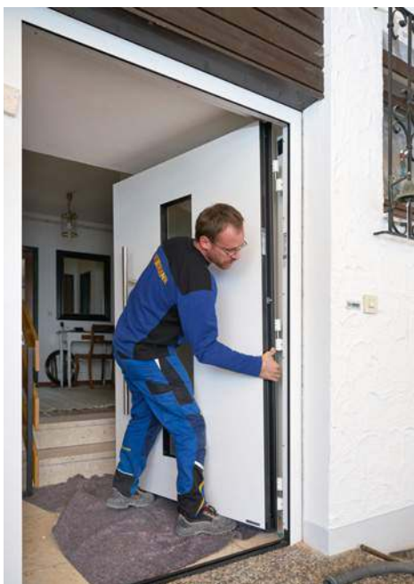
❷ Skrzydła drzwiowe sporo ważą, dlatego zamocowanie ościeżnicy powinno być mocne i stabilne. HÖRMANN, PORTA
