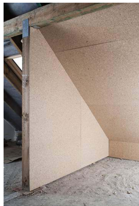
🔍 Przy wykańczaniu poddasza sprawdzi się wiórowa płyta mfp, która dobrze izoluje akustycznie. PFLEIDERER
