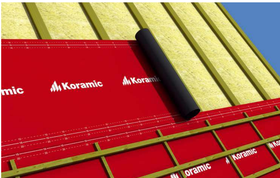
Wykonanie nowego pokrycia obejmuje ułożenie ocieplenia i membrany dachowej. WIENERBERGER
