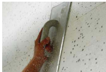
6 Szlifowanie powierzchni płyt styropianowych pacą z grubym papierem ściernym.
