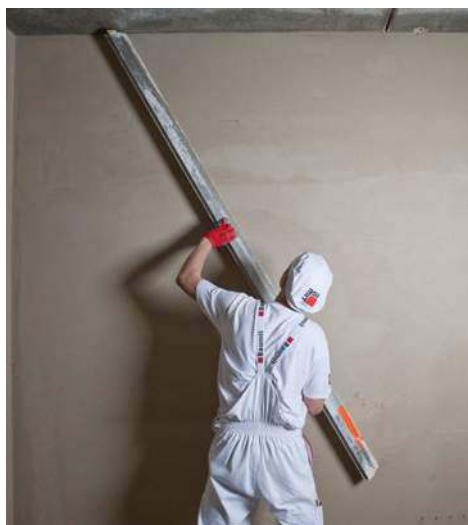
🔧 Wyrównywanie wstępnie związanego tynku za pomocą łąty (a) oraz zacieranie końcowe (b). BAUMIT
