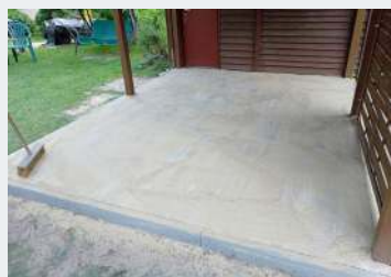
Podłoga z płyt betonowych (widok zaraz po realizacji), ułożonych metodą na sucho, jest lepsza od drewnianej.
