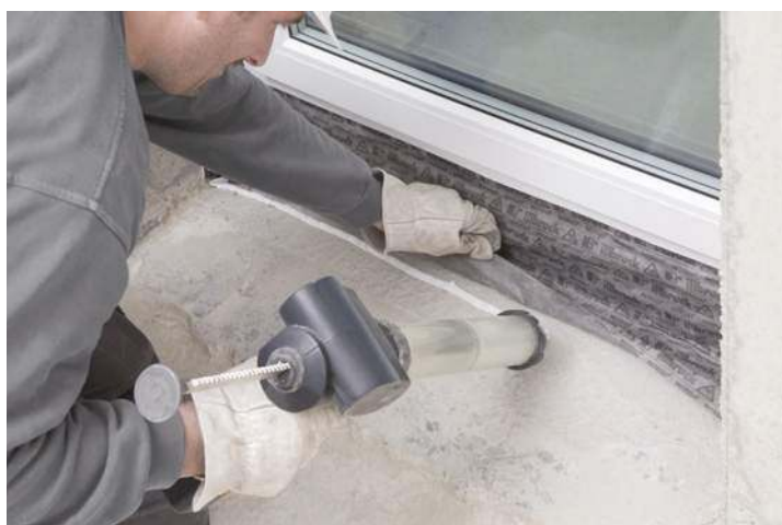
🔧 Aby nie dopuścić do zawilgocenia pianki montażowej, należy zastosować tzw. montaż warstwowi, z użyciem taśm zabezpieczających. ALUPLAST, REHAU
