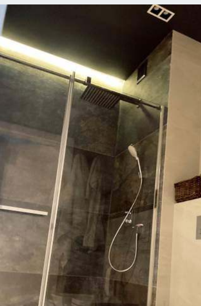
Nad wnęką z prysznicem ulokowano taśmę LED, w podwieszanym suficie (czarnym) – halogeny.
