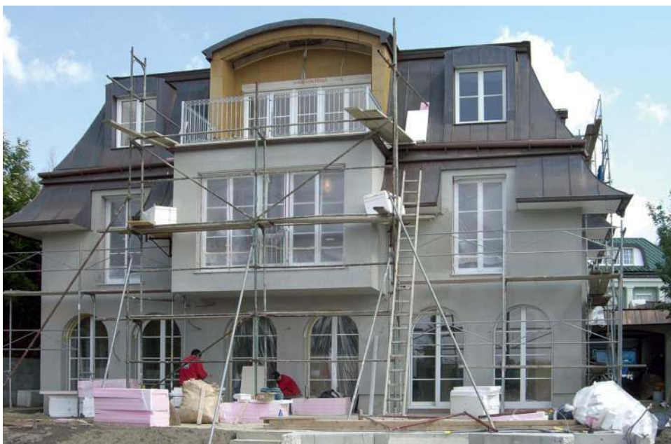
🔧 Budynki mające 20 lat lub starsze zwykle wymagają kompleksowej termomodernizacji – z wymianą okien, dociepleniem dachu i elewacji. BAUMIT
