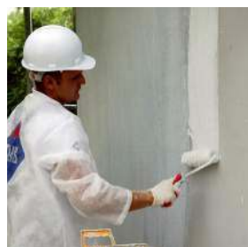
9 Gruntowanie podłoża.
