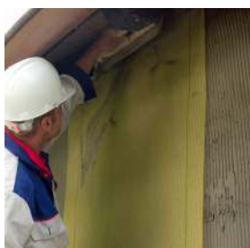
8 Wykonanie warstwy zbrojonej zaprawą klejącą z siatką z włókna szklanego.
