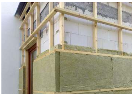
➋ Wypełnienie rusztu wełną mineralną.
