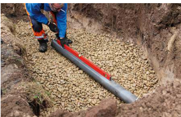
🔧 Oczyszczalnia z drenażem to u nas wariant najpopularniejszy. J. WERNER
