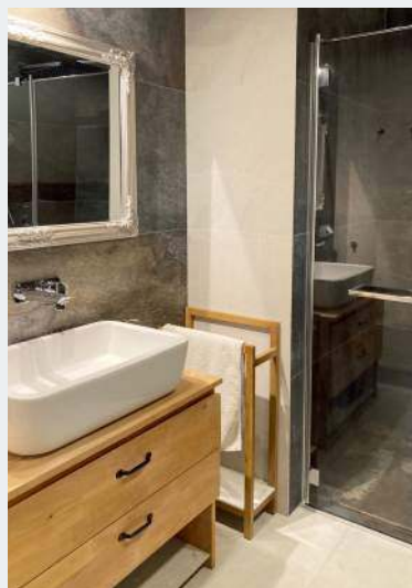
Nad nablatową umywalką zamontowano podtynkową chromowaną baterię, lustro, kinkiety.
