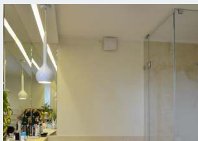
Zmodernizowano oświetlenie na ledowe (halogeny i taśma nad lustrem).
