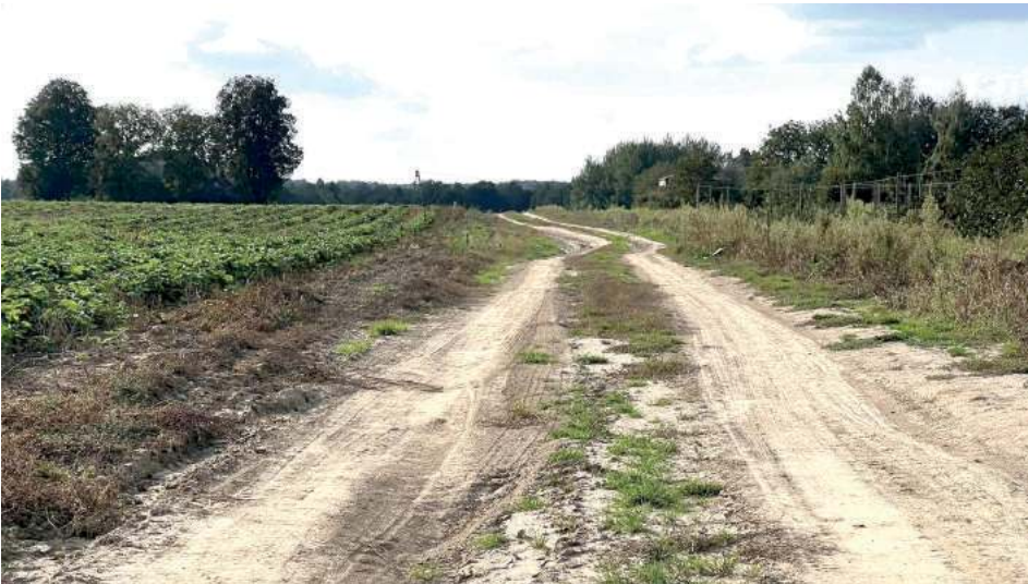
O budowę drogi z prawdziwego zdarzenia mieszkańcy Celejowa wspierani przez radnych zabiegali od kilku lat. Dzięki pozyskanej przez gminę dotacji ich marzenie o komfortowym dojeździe do domu stało się realne
