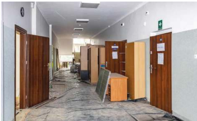
Prace remontowe trwają. SP w Zakroczymiu
