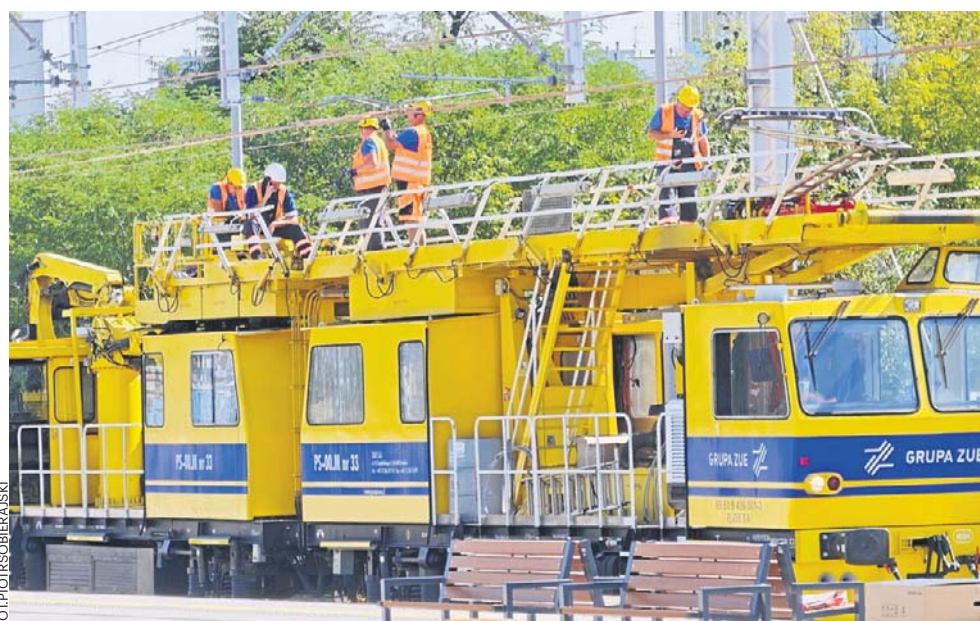
Ostatnio trwały intensywne prace na wybudowanych od nowa peronach nr 1 i 2 na stacji Sosnowiec Główny. Od 9 września znów wrócili na nie pasażerowie
