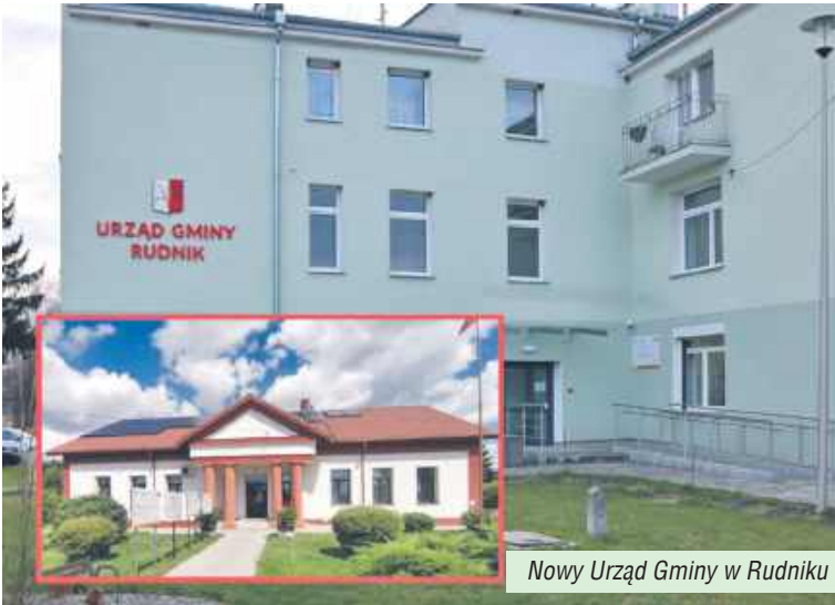
Szkoła w Rudniku po termomodernizacji
