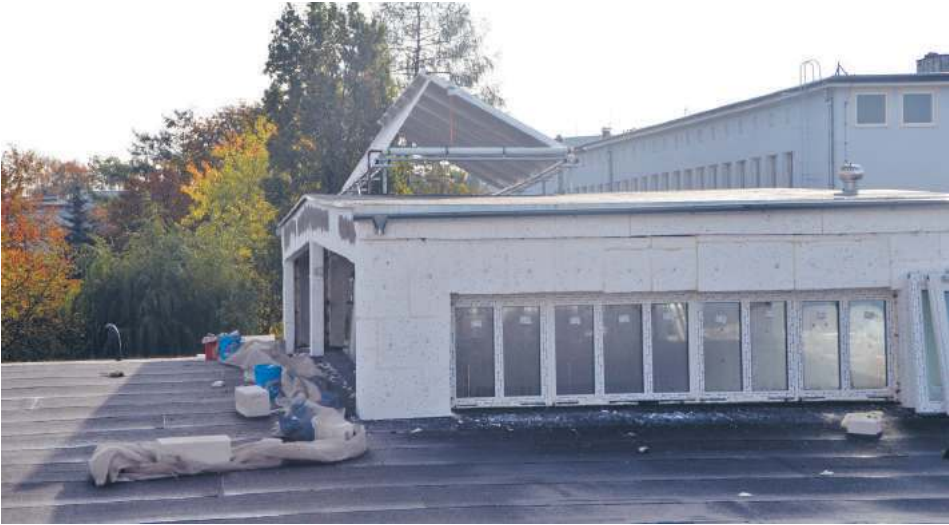
Modernizacja Centrum Kształcenia Praktycznego PCEZ dobiega końca
