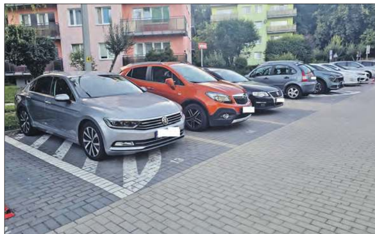
Zatarasowana droga pożarowa
