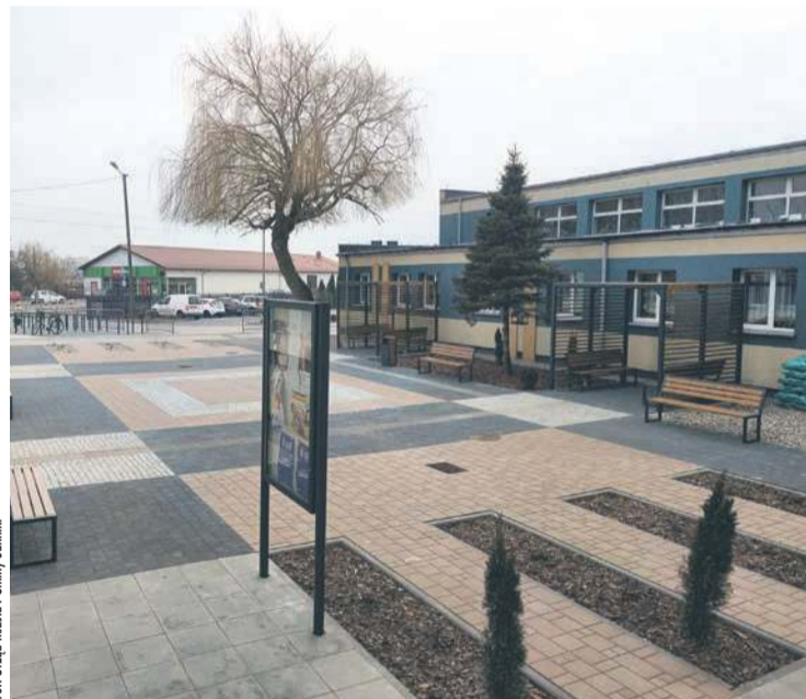
W ramach inwestycji poprawiającej dostępność szkoły w Sannikach m.in. wykonano ciągi pieszkie o odpowiedniej szerokości
