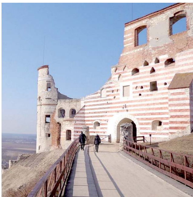
Odwiedzając janowiecki zamek zwykle nawet nie zwracamy uwagi na drewniany mostek prowadzący do bramy. Jest on jednak ważną częścią obiektu. Samo wejście do zamku ma ciekawą historię – choć dziś trudno to sobie wyobrazić, w dawnych czasach do zamku prowadził most zwodzony nad głęboką fosą
