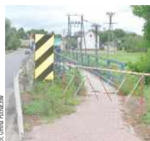
Remontowana kładka na rzece Świnka
