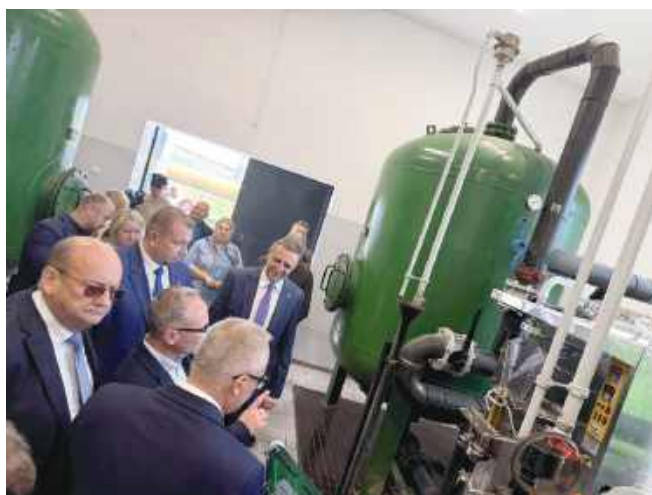
■ Ujęcia w gminie pochodzą z lat 90-tych i przechodziły różne większe, mniejsze modernizacje, ale istniała konieczność ich gruntownej modernizacji
