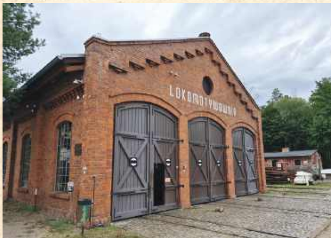
■ Z dawnej zabudowy stacji do dziś zachowały się lokomotywnia i wagonownia. Stoi tu także parterowy budynek z muru pruskiego, w którym dawniej naprawiano wagony i mieściła się stolarnia. FOT. DAWID MACHECKI
