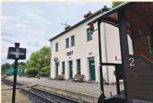
■ Pierwotny dworzec w Rudach był dwupiętrowym budynkiem, w którym mieściły się m.in. poczekalnia, kasa, nastawnia i biuro zawiadowcy. Spłonął pod koniec II wojny światowej. Po wojnie odbudowano go w zupełnie innej formie. Z dawnego budynku zachowały się jedynie piwnice.
