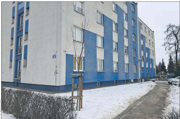
Budynek Bursy Płockiej przejdzie termomodernizację
