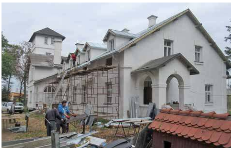
Właściciele już naprawiają dach
