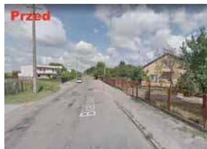
Białowiejska przed remontem
