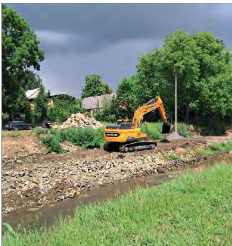
Historyczny moment rozpoczęcia prac popowodziowych
