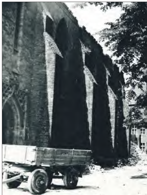
Cegły z rozbiórki były cennym materiałem budowlanym
