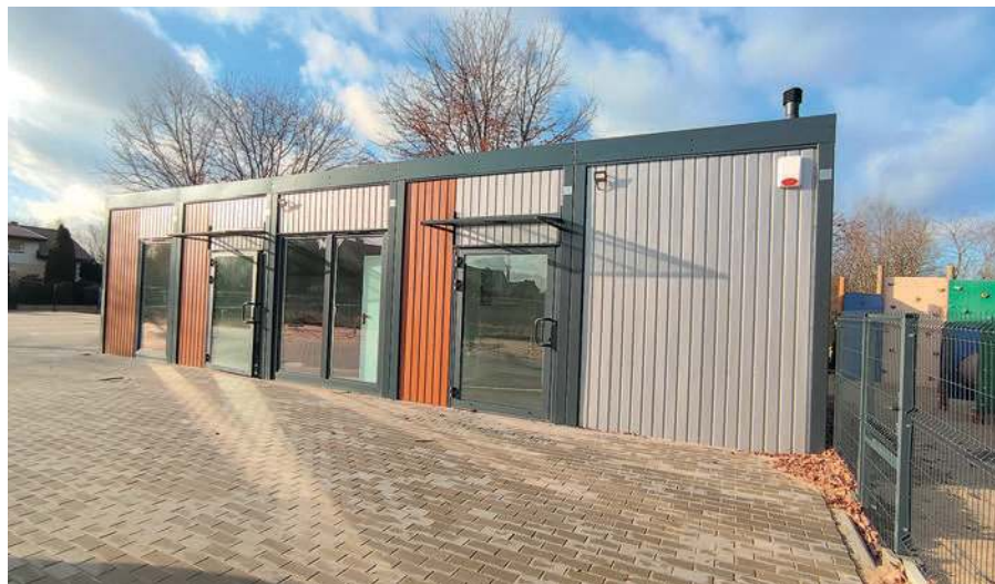
Budowa świetlicy kontenerowej w Nużewie
