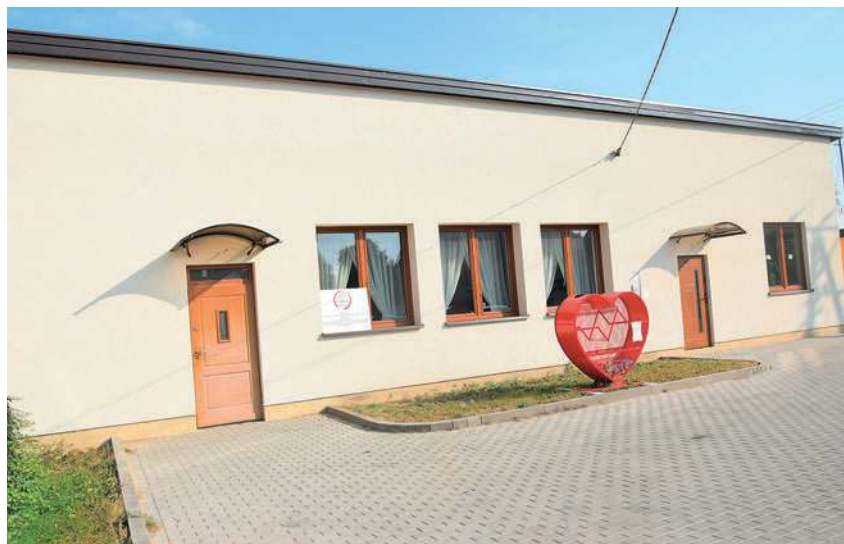
Remont świetlicy wiejskiej w Rydzewie
