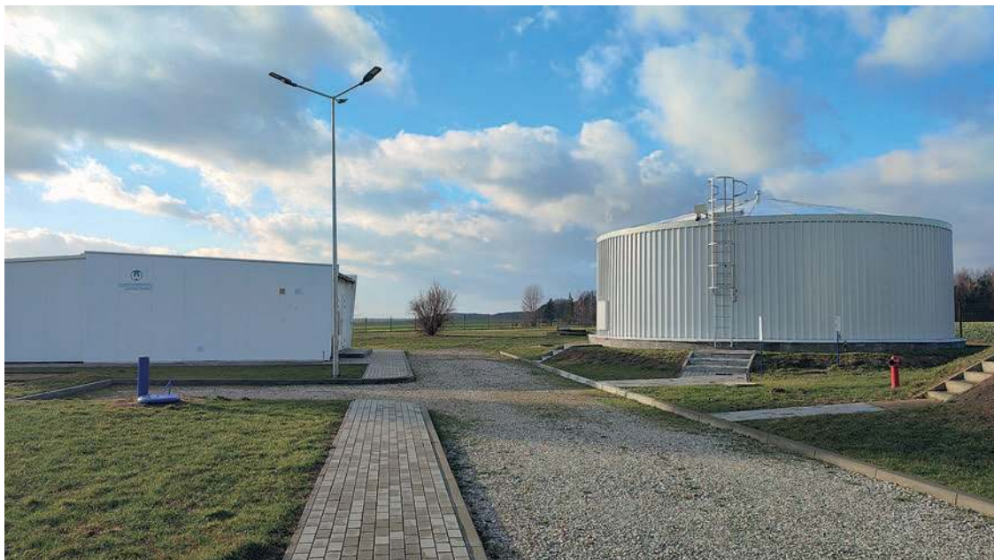
Modernizacja Stacji Uzdatniania Wody w Gumowie
