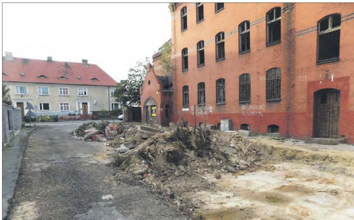
Jezdnia i chodnik są już wyremontowane, budynek nie
