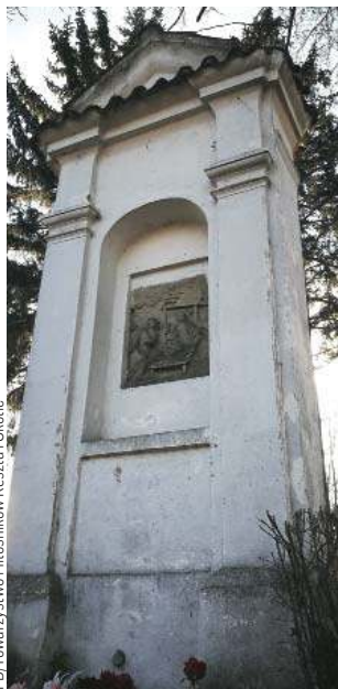
Kolejna kapliczka doczeka się remontu. Potem przyjdzie czas na kolejną
