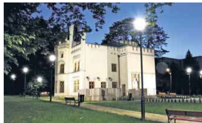
Odbudowa pałacu kosztowała ok. 11,6 mln zł, z czego dofinansowanie unijne to ponad 5,5 mln zł
