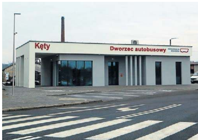
Dworzec autobusowy w Kętach. W sąsiedztwie jest parking mogący pomieścić 80 samochodów
