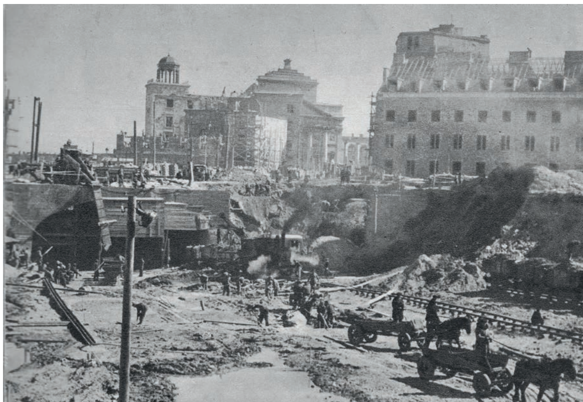
Budowa tunelu, widok od strony zachodniej, 1948
