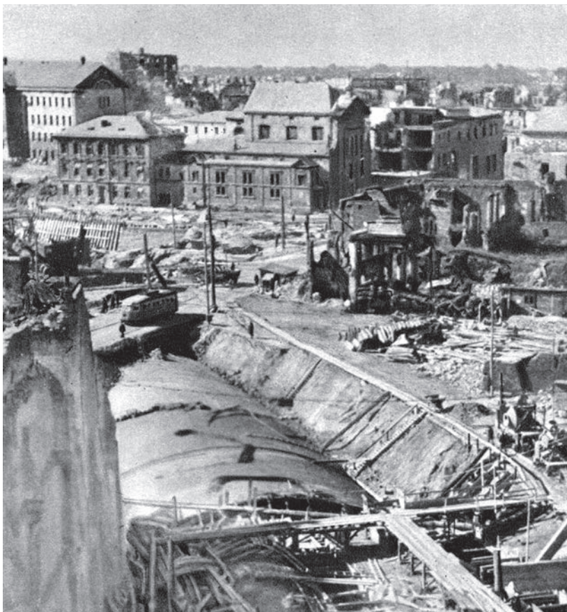
Betonowanie stropu tunelu, 1948 r., źródło: domena publiczna
