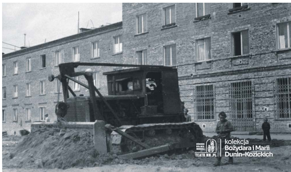
Budowa ZOR Bronowice I
