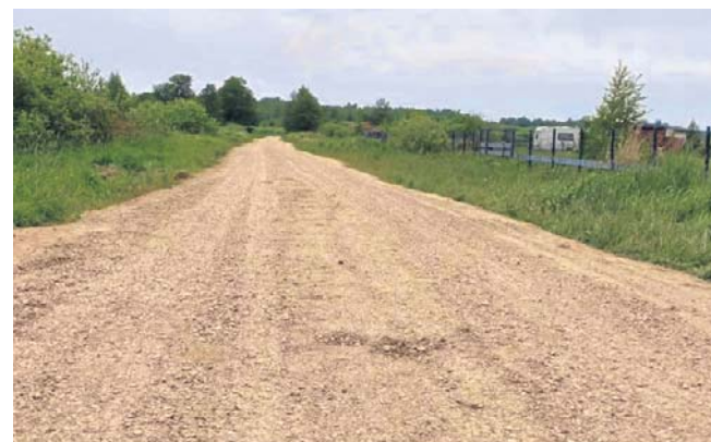
Nowa droga została wyrównana i zostanie oznakowana
