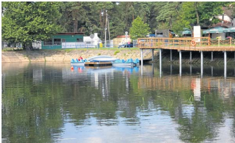
Zakończyła się przebudowa kąpieliska w Żarkach Letnisku. Tak teraz wygląda popularny obiekt
