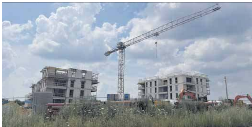
Osiedle Skałka w Jaworznie – budowa III etapu
