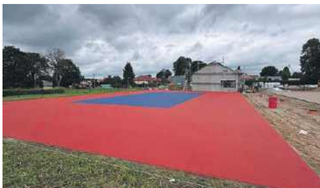
Budowa orlika w Konikowie
